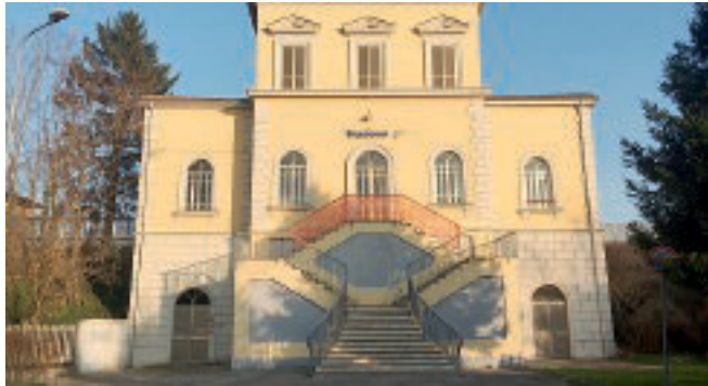
SCALE IMPOSSIBILI L'ingresso della stazione di Colorno.
